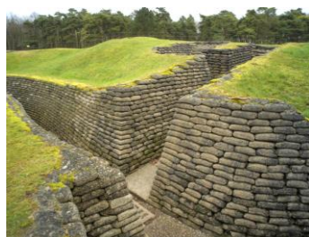
Tranchées de Vimy
