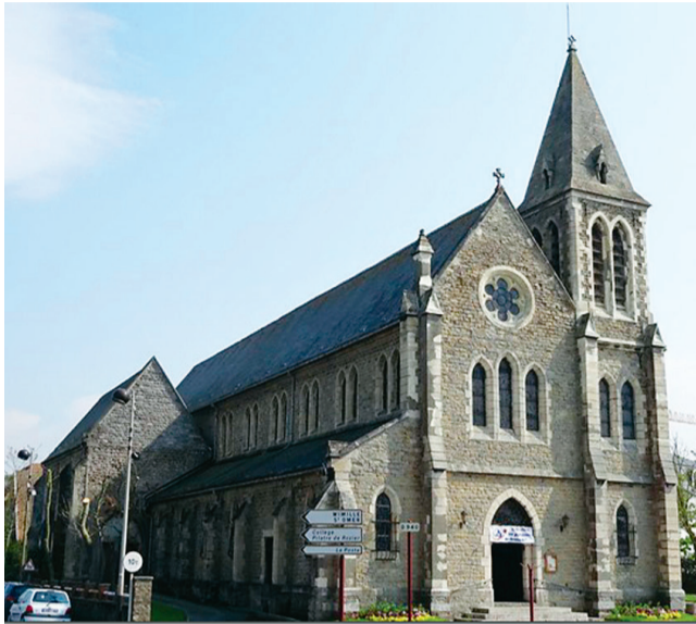
La première pierre a été posée en novembre 1866. L'église, inaugurée en 1868, souffre 150 ans plus tard de graves problèmes de toiture.
